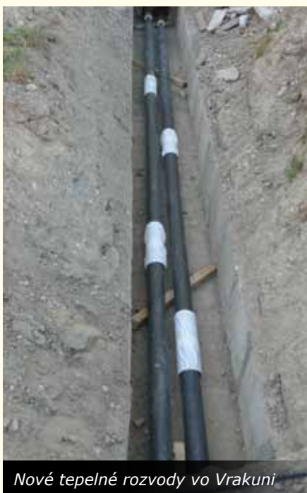
Nové tepelné rozvody vo Vrakuni
