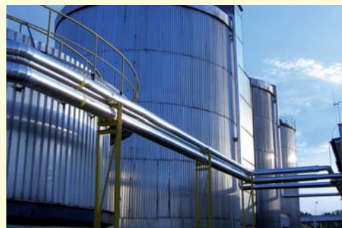
Vymenené bioplynové potrubné rozvody v Senici
