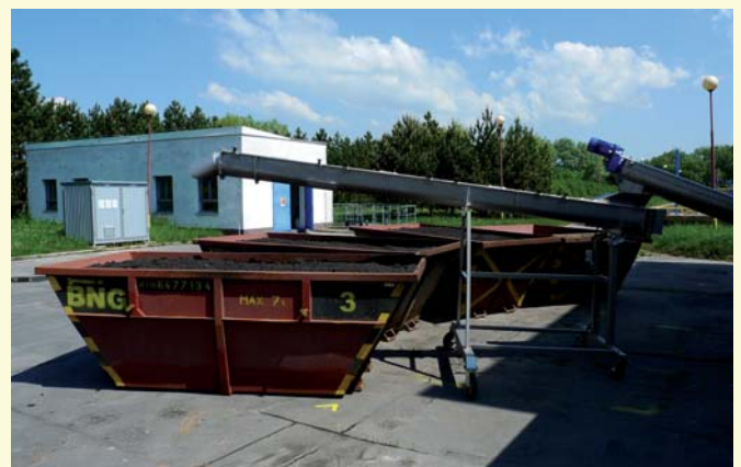
Dopravník odstredeného kalu v Devínskej Novej Vsi
